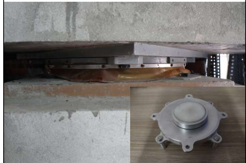
低摩擦すべり免震装置
